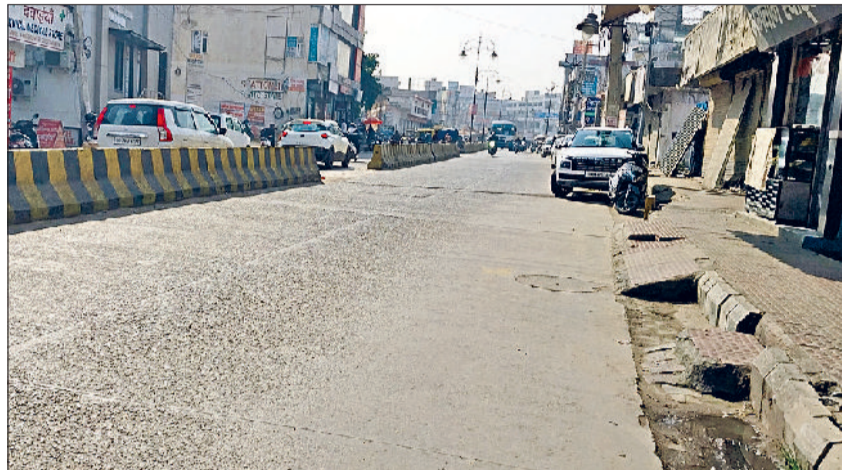
रेवाड़ी। सरकुलर रोड पर धारूहेड़ा चुंगी मार्ग, जहां जनवरी में नए सीसी रोड का कार्य शुरू होगा। फोटो: हरिभूमि
